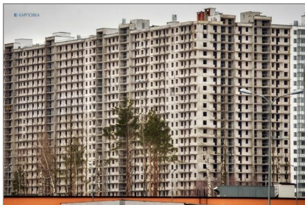
Рис.9. Строящееся здание ЖК «Граффити» [18]
