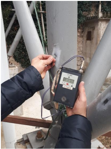
Рис. 2. Измерение толщины элементов стеновой панели по оси 2
