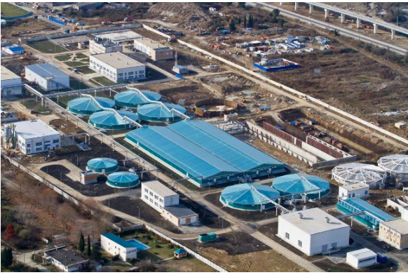
Рис.3. Очистные сооружения канализации города Сочи
