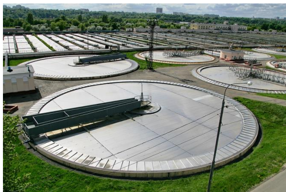
Рис.2. Блок первичных отстойников Курьяновской станции аэрации
