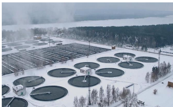
Рис.1. Очистные сооружения канализации города Новосибирска
