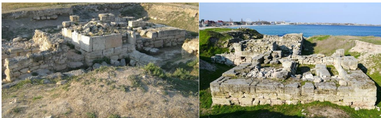
Рис.8. Фундаменты сторожевых башен Калос Лимен Fig.8. Foundations of the Kalos Limen watchtowers
