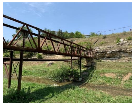
Рис. 7 Металлический мост Fig. 7 Metal bridge
