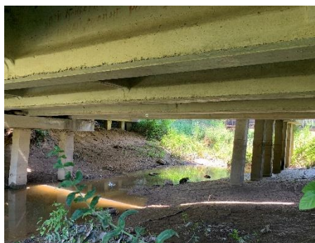
Рис. 6 Железобетонных мосты на сваях Fig. 6 Reinforced concrete bridges on stilts
