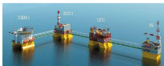
Рис. 1. Комплекс сооружений для обустройства месторождения им. В. Филановского.
