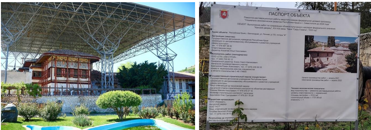
Рис. 13. Паспорт объекта на выполнение ремонтно-реставрационных работ» (слева); защитные сооружения над Ханским дворцом, 2022-2023 г. (справа) Fig. 13. Passport of the object for repair and restoration work" (left); protective buildings over the Khan's Palace, 2022-2023 (right)
