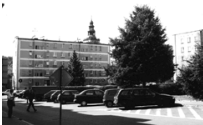
Рис. 5. Лидзбарк Варминский – архитектура застройки стороны рынка.
