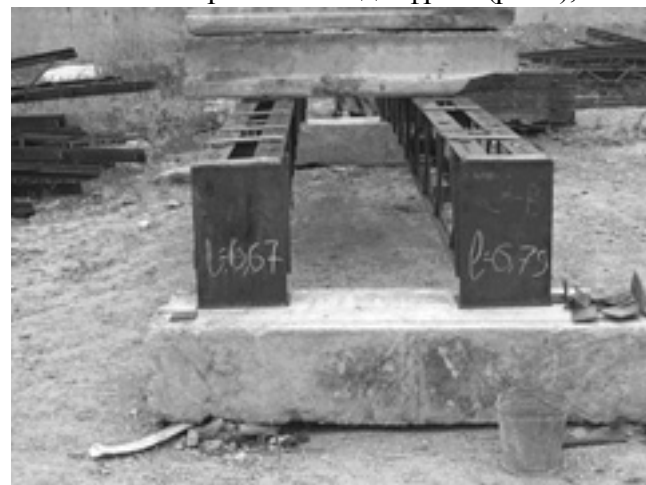
Рис.3 Опорные части подстропильных конструкций
