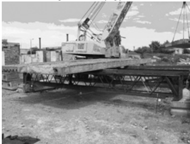
Рис.5 Загрузка подстропильных конструкций железобетонными плитами
