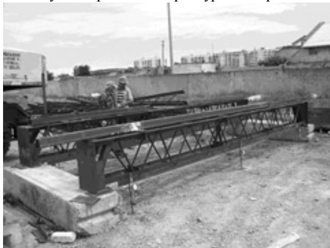
Рис.1 Общий вид подстропильных конструкций перед испытаниями
