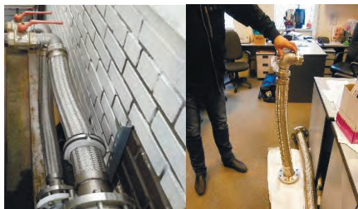
Рис.4. Виброизоляция трубопроводов с помощью гибких вставок
