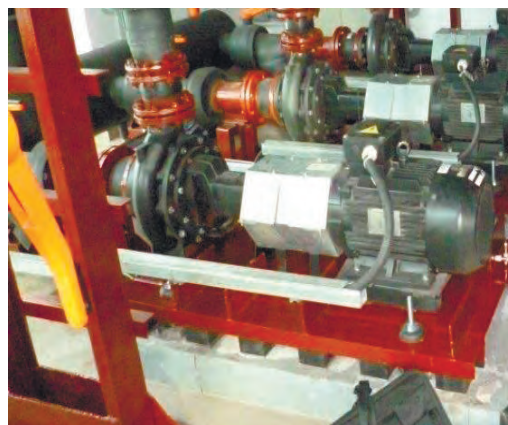
Рис. 2. Виброизоляторы ВИ-1 под нагрузкой
