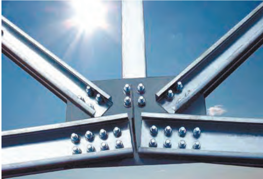
Рис. 1. Узел соединения профилей стержневой конструкции
