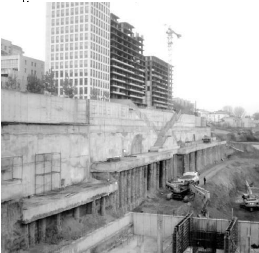
Рис.1. Разработка грунта перед свайной удерживающей конструкцией [4]
