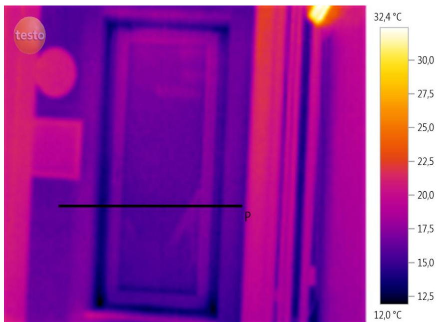
Рис.1. Снимок светопрозрачного проема с установленной панелью
