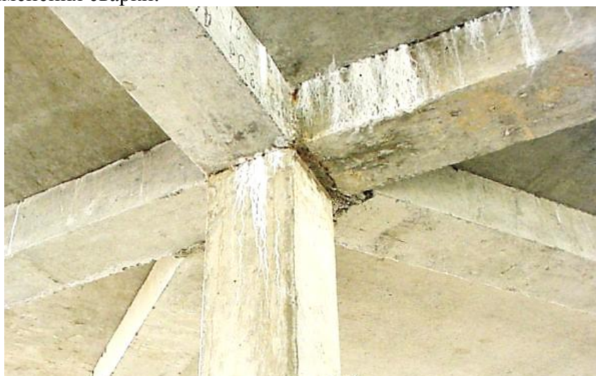
Рис. 2. Фрагмент опирания ригелей на колонну
