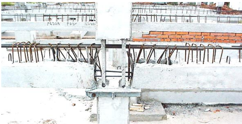
Рис. 1. Узел сопряжения колонна-ригель
