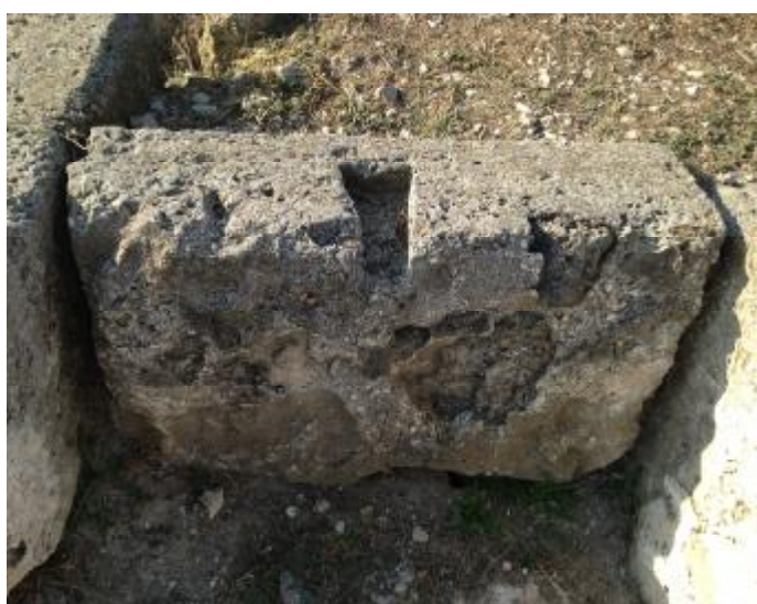
Рис. 16. Каменный блок с отверстием для подъемного механизма «волчья пасть», найденный на городище Калос Лимен
