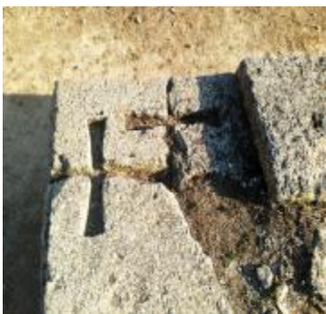
Рис. 8. Пример использования угловой кладки «en besace» на территории городища Калос Лимен
