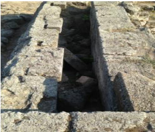
Рис. 4. Тип D. Фрагменты двухпанцирных стен историко-археологического заповедника Калос Лимен
