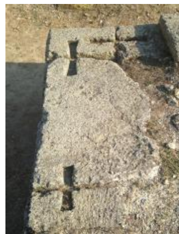
Рис. 21. Углубления для металлических скоб «ласточкин хвост» в стенах Калос Лимена
