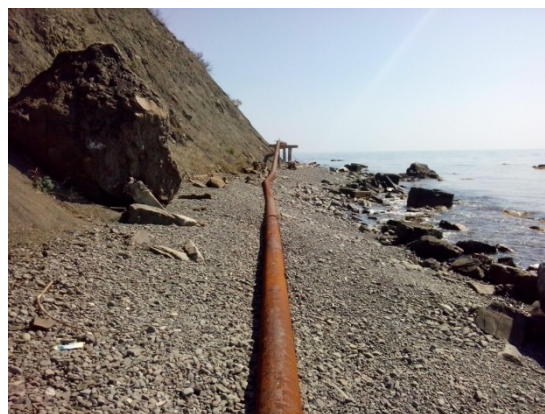
Рис. 5. Стальной водовод длиной 20 км, диаметром 250-500мм
