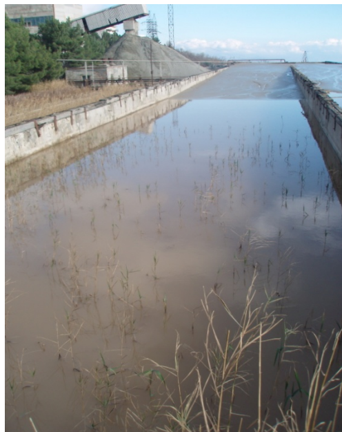
Рис. 2. Шламоотстойник Шархинского карьера объемом 5 тыс. м 3
