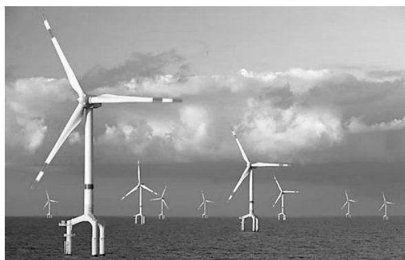
Рис. 6. Фото ВЭС на шельфе Северного моря в Германии
