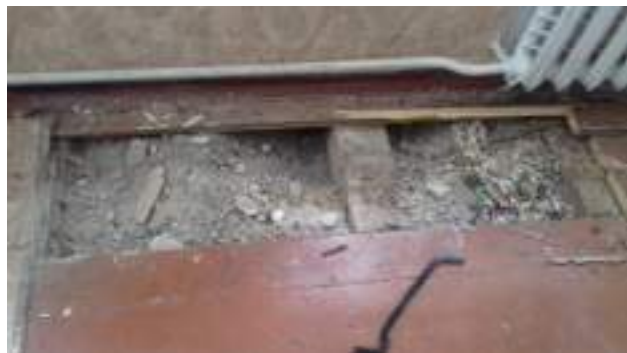
Рис. 1 – Вскрытие перекрытие по деревянным балкам.
