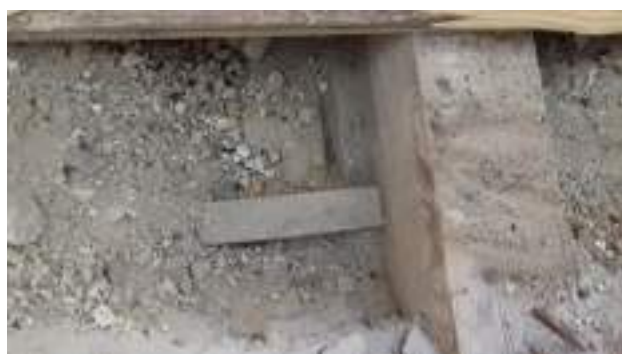
Рис. 2 – Деревянные балки, поперечные бруски, черепные бруски, накат.
