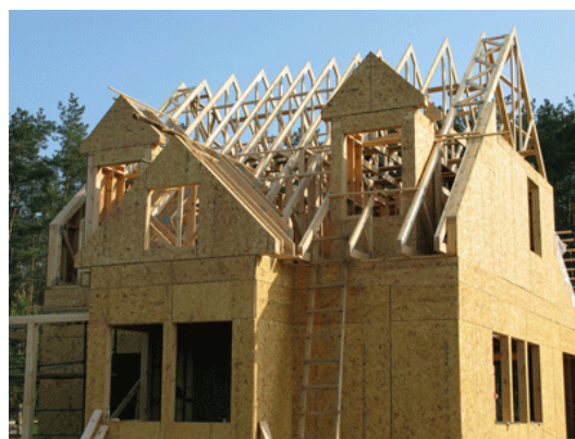
Рис. 1. Двухэтажное здание с деревянным каркасом
