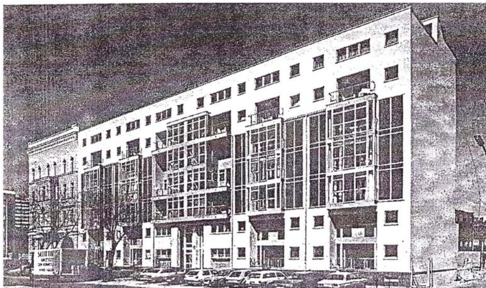
Рис.7. Стены Тромба - Мишеля в многоэтажном здании на Лютцовштрассе в Берлине. Солнечные камины (стены Тромба), зимние сады (глубокие лоджии) интегрированы в фасад. Проектный институт ИБУС, Берлин, 1988 г. Fig.7. The walls of Tromb - Michel in a multi-storey building on the Lutzovstraße in Berlin. Solar fireplaces (Tromb walls), winter gardens (deep loggias) are integrated into the facade. Project Institute, IBES, Berlin, 1988.
