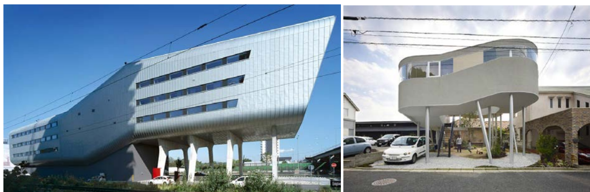
Рис. 4. Надземные дома: спортивно-оздоровительный центр RELAXX (Словакия) (слева), дом Toda в г. Хиросима (Япония) (справа)
