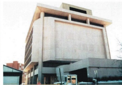
Северный фасад здания
