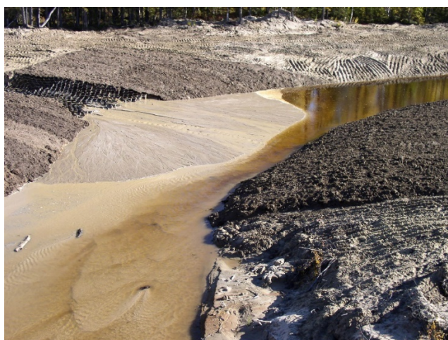
Рис. 3. Размытие грунта в месте подводного перехода газопровода через реку
