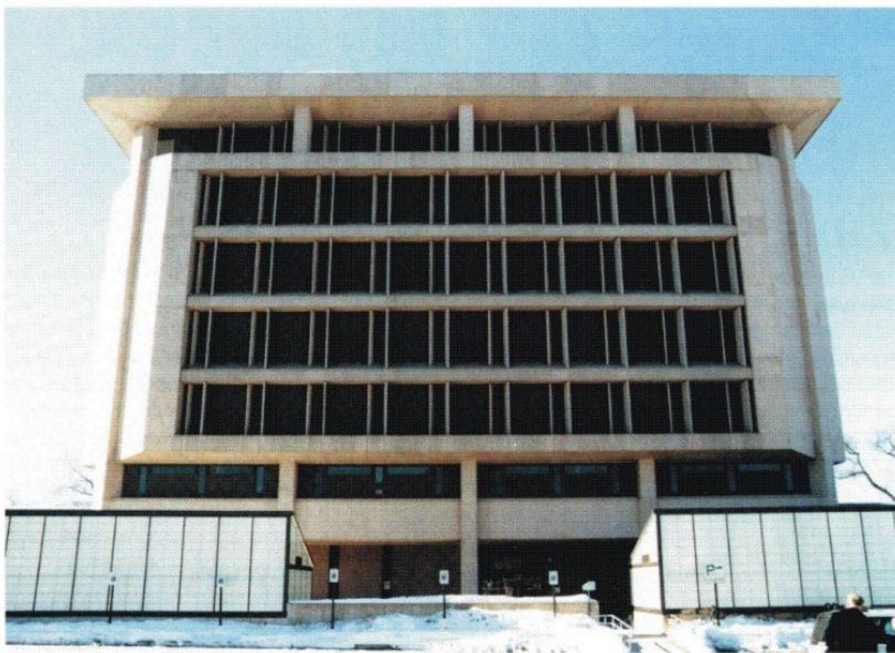
Восточный фасад здания
