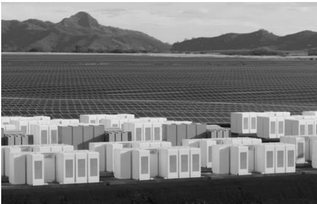
Рис. 1. Внешний вид СЭС на острове Кауаи (Kauai) Гавайского архипелага. На переднем плане - блоки НЭ общей ёмкостью 52 МВт·ч
