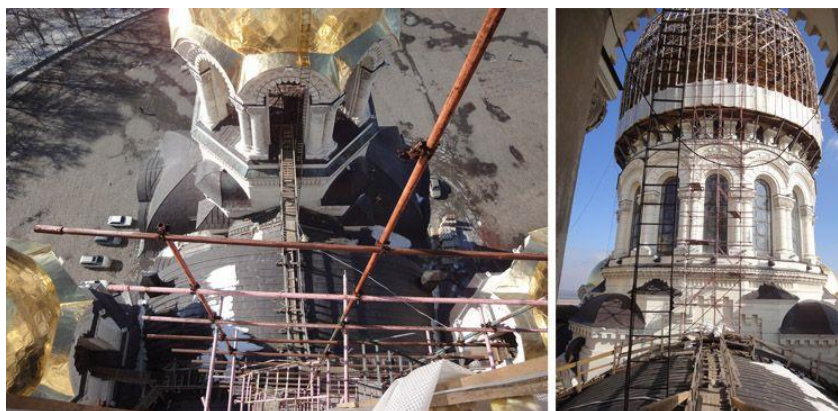
Рис. 4. Оштукатуривание собора
