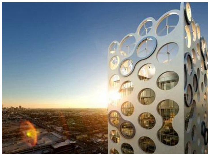
Рис8. COR building. Ветряные турбины.
