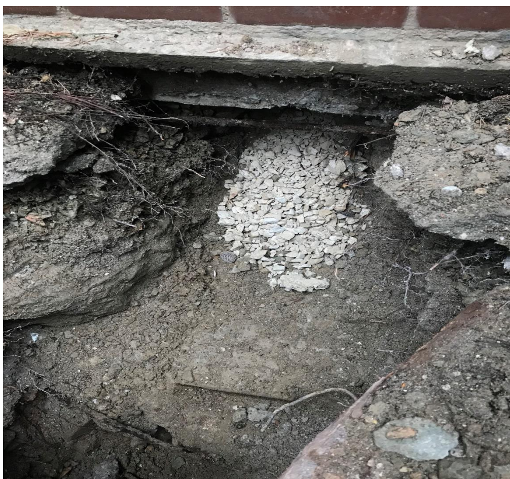
Рис. 7. Начальный этап разработки шурфа.
