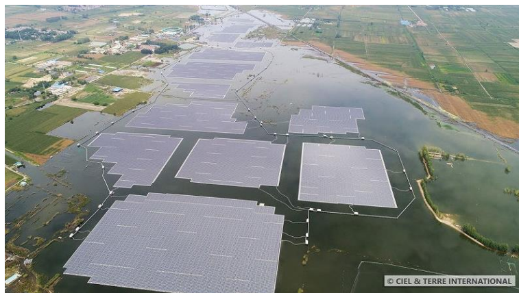
Рис. 3. Плавающая солнечная электростанция мощностью 70 МВт. Fig. 3. 70 MW floating solar power plant.
