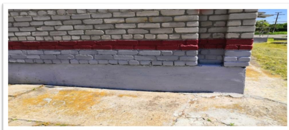
Рис. 5. Отмостка Fig. 5. Blind area
