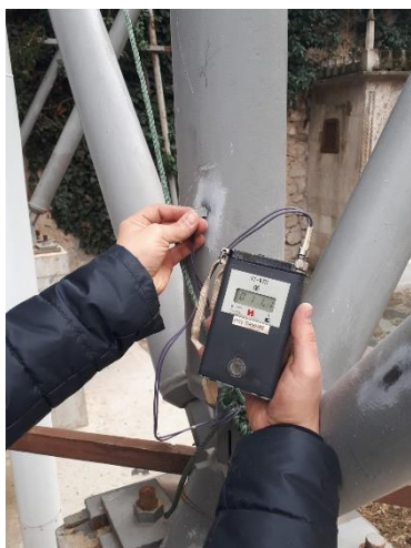
Рис. 2. Измерение толщины элементов стеновой панели по оси 2
