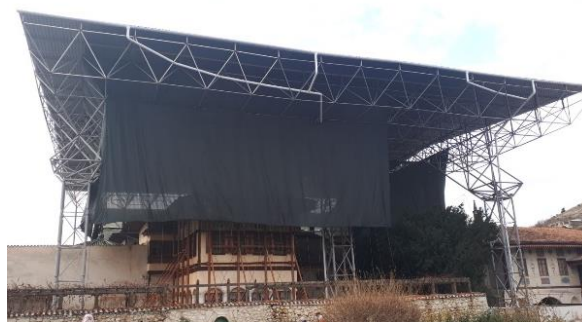
Рис. 1. Общий вид навеса по оси 1 Fig. 1. General view along axis 1
