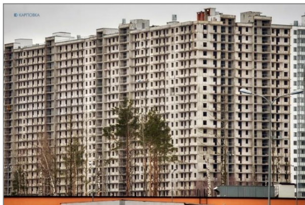
Рис.9. Строящееся здание ЖК «Граффити» [18]
