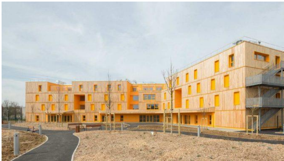
Рис. 4. Облицовка фасада дома престарелых Morangis Retirement Home Fig. 4. Facade cladding of Morangis Retirement Home
