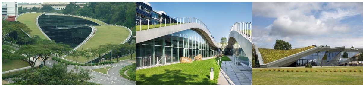
Рис. 4. Варианты озеленения кровли: Наньянский технологический университет (Сингапур) (слева); Marcel Sembat High School (Франция) (в центре); ресторан Royal Beach (Крестовский остров, Санкт-Петербург) (справа).
