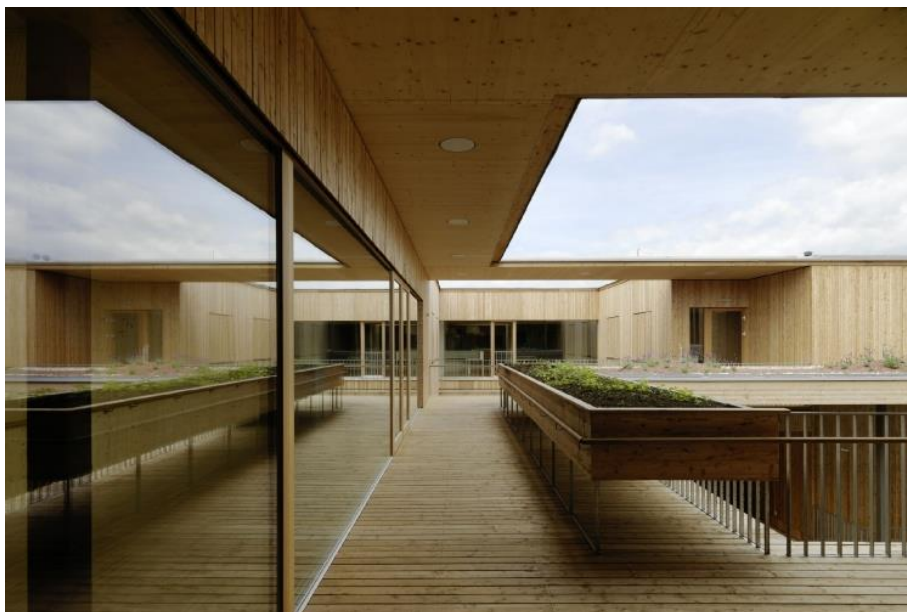
Рис. 5. Облицовка фасада дома престарелых имени Петра Розеггера Fig. 5. Facing the facade of the Peter Rosegger Nursing Home
