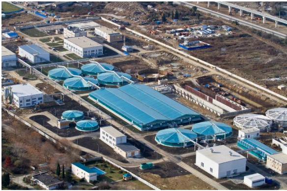
Рис.3. Очистные сооружения канализации города Сочи
