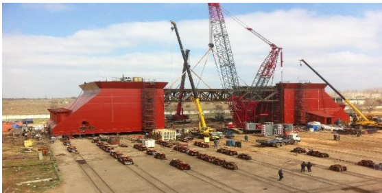
Рис. 2. Момент объединения опорных блоков платформы стальной укрупнительной рамой на строительной площадке
