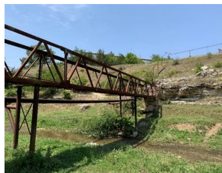
Рис. 7 Металлический мост Fig. 7 Metal bridge
