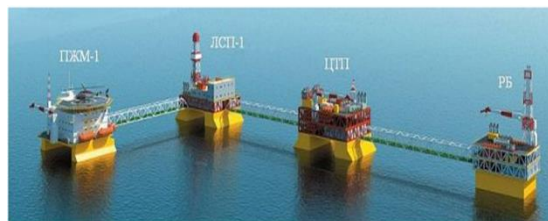
Рис. 1. Комплекс сооружений для обустройства месторождения им. В. Филановского. Fig. 1. A complex of facilities for the development of the field named after V. Filanovsky
