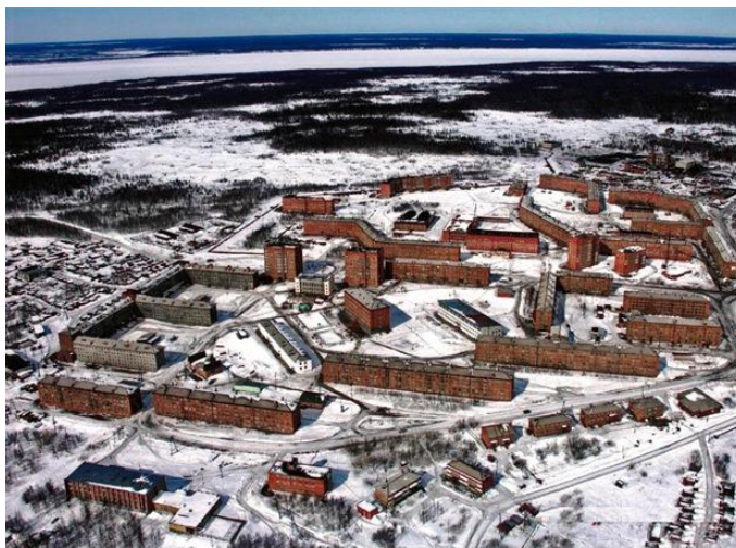
Рис. 1. Общий вид г. Игарка Fig. 1. General view of Igarka
