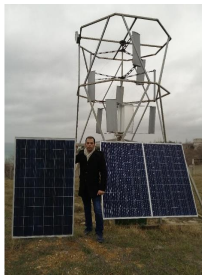
Рис. 9. Ветер / солнечная гибридная система питания на полигоне Сев ГУ на турбазе Горизонт Fig.9. Wind / solar hybrid power system in garizont
