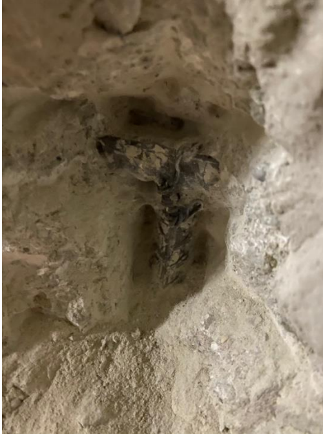
Рис. 3. Вскрытие железобетонной конструкции Fig. 3. Opening of a reinforced concrete structure
