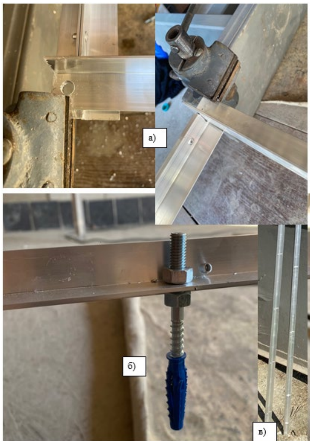
Рис. 4. Сверление отверстий под анкеры крепления к стене с регулировкой положения элементов штукатурной рамы на ней: а) – по углам рамы); б) – промежуточных; в) – общий вид готовых вертикальных стоек перед монтажом на стене Fig. 4. Drilling holes for anchors to the wall with adjustment of the position of the elements of the plaster frame on it: a) – at the corners of the frame); б) – intermediate; в) – a general view of the finished vertical racks before mounting on the wall
