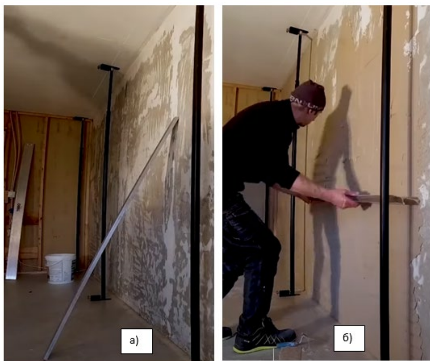
Рис.1. Монтаж телескопических стоек-направляющих (а) и разравнивание раствора рейкой-правилом с упором в полученные таким образом маяки (б) по норвежской технологии оштукатуривания Fig.1. Installation of telescopic guide rails (a) and leveling of the mortar with a rule with an emphasis on the beacons obtained in this way (b) according to Norwegian plastering technology
