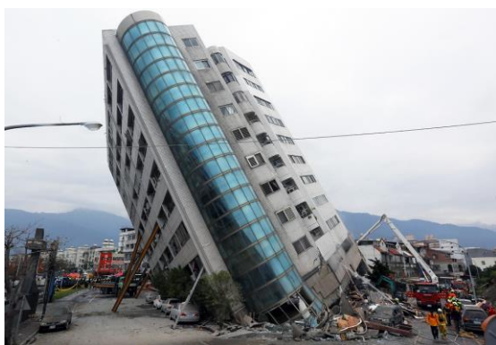
Рис. 7. Землетрясение на Тайване. 21 сентября 1990 года Fig. 7. Earthquake in Taiwan. September 21, 1990
