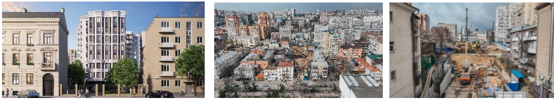
Рис. 2. Строительная площадка 11-этажного многоквартирного жилого дома по ул. Пушкинская 97, г. Ростов-на-Дону. Fig. 2. The construction site of an 11-storey apartment building on 97 Pushkinskaya Street, Rostov-on-Don.
