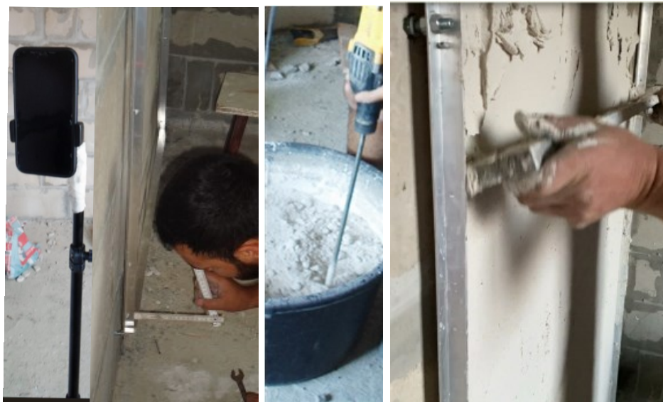
Рис. 1. Видеофиксация операций приготовления, нанесения и разравнивания раствора правилом под окончательную отделку оштукатуренная поверхность перегородки с использованием установленной и выверенной технологической оснастки – штукатурной рамки из алюминиевых уголков подобранного поперечного сечения.
