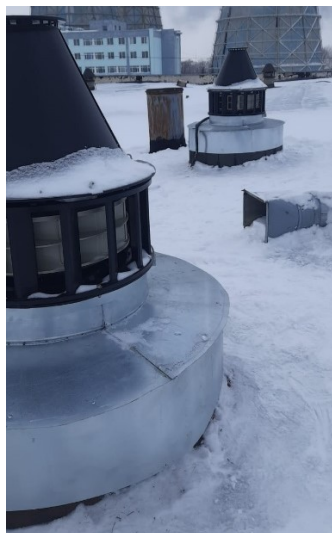
Рис. 5. Утепленные монтажные стаканы для вентиляторов из химически стойкого пластика диаметром 630 мм с встроенным обратным клапаном. Fig. 5. Insulated mounting cups for fans made of chemically resistant plastic with a diameter of 630 mm and a built-in check valve.
